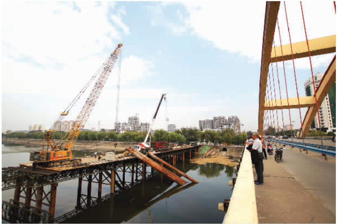
紧张搭建的便桥引来市民驻足观看
