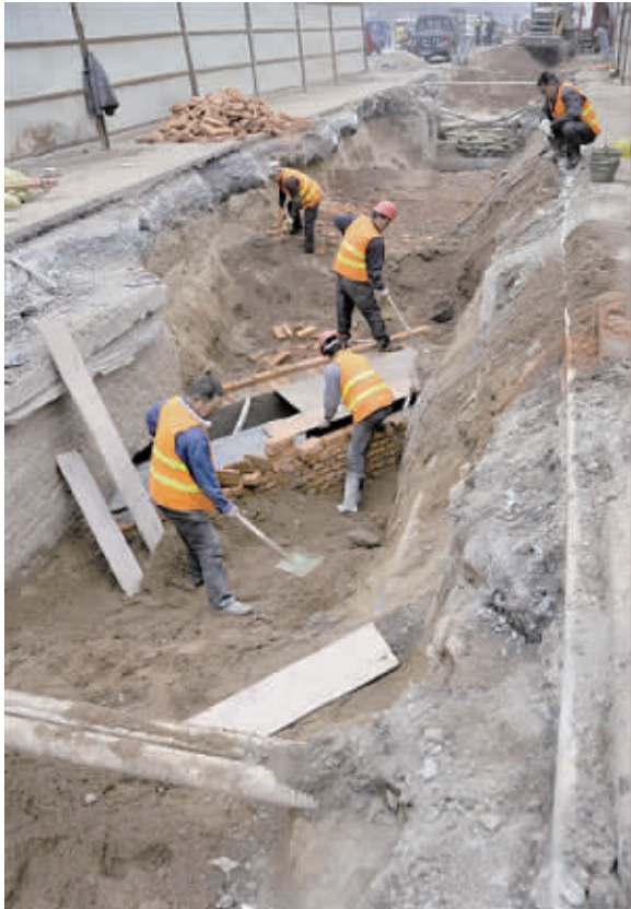
图为施工现场 本报记者 黄宁 摄
