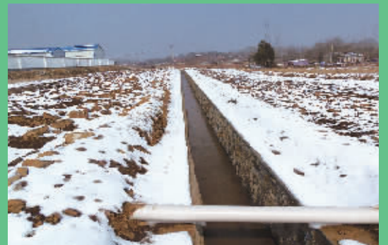
吴家店镇湖塘村扶贫项目——引水灌渠
