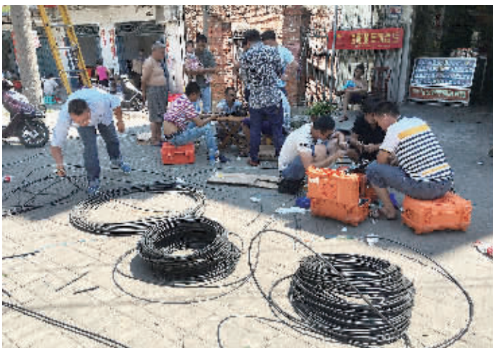
工作人员正在抢修通信电缆。见习记者 李倩 摄
