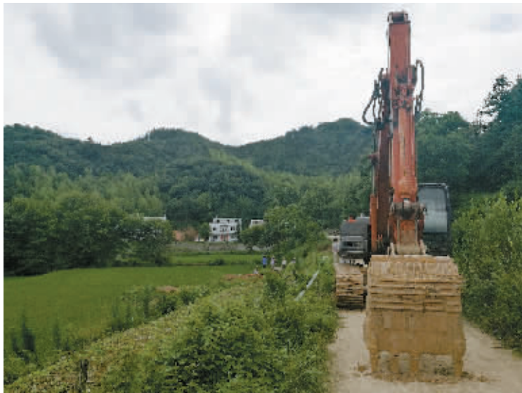
行走灾区,挖掘机和叉车随处可见,汛期尚未结束,干群严阵以待!
