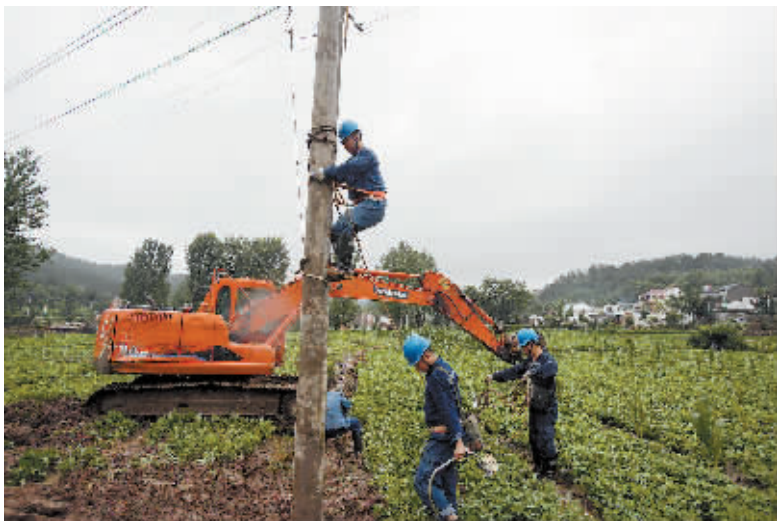
电力工人正在抢修倒伏的电线杆,确保灾区电力畅通。
