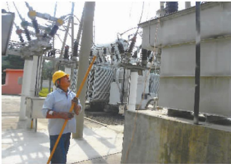
昨日,为迎接即将到来的夏峰,信阳供电公司110千伏宝石桥变电站2号变增容,将原有的3.15兆伏安变压器更换5兆伏安容量变压器,以提高供电可靠性。图为更换变压器前运维人员进行倒闸操作。方菲摄
