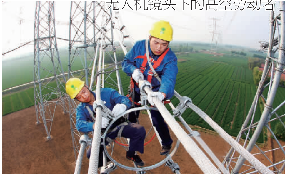
1000千伏锡盟-山东特高压工程系国家大气污染防治行动计划重点工程,全长730公里,输电容量900万千瓦。工程投运后将对清洁能源供应,大气环境治理发挥重大作用。图为4月29日国网山东电力检修公司技术人员在济阳县对工程进行验收。(据新华网)
