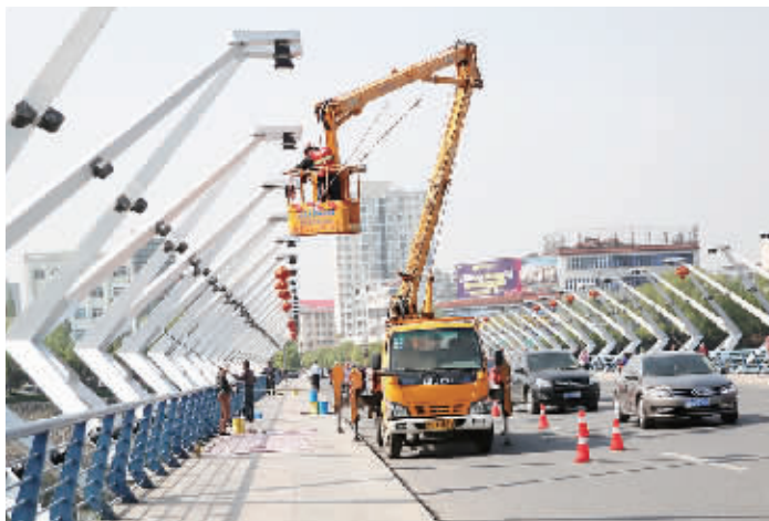
施工人员正对关桥重新刷漆。见习记者 郭晓雨 摄
