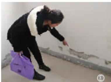
①②外墙裂痕 ③墙壁脱皮有裂纹
