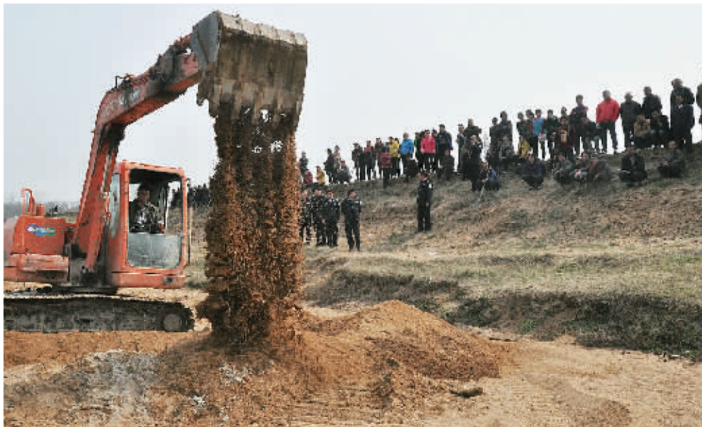
挖掘机当众重新深翻事发河滩
