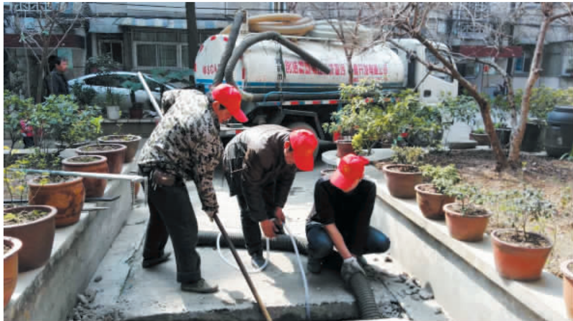
在全国第 53 个“学雷锋纪念日”来临之际,市盐业局和工区路工区社区响应市文明委的号召,组织学雷锋志愿服务队进入“盐业小区”清理化粪池,提供便民利民等志愿服务,使广大群众感受到社区的关爱。图片为志愿者在清理化粪池现场。
