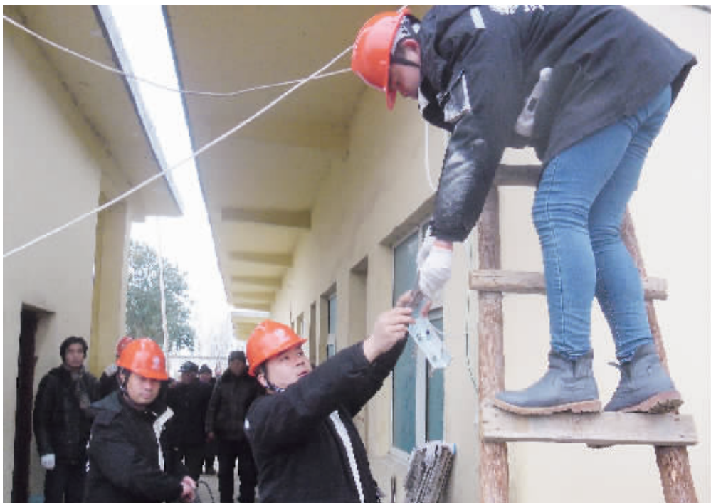
春节期间,息县白土店乡供电所的工作人员到该乡夏寨村养老院排查电力安全隐患。图为电力人员正在整改老化线路。周磊 摄
