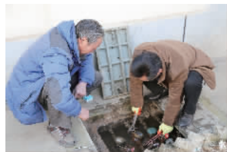
工作人员正不顾严寒紧张施工
