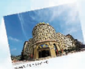
小镇内新建的传统民居建筑，风格独特。
