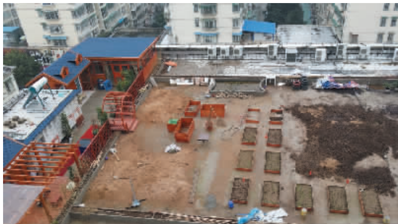
建设中的“空中花园”
