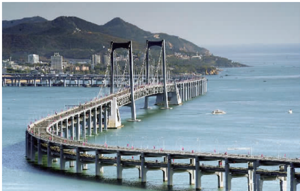
这是 10 月 30 日拍摄的大连星海湾跨海大桥。当日,历经 4 年施工建设的大连南部星海湾跨海大桥竣工通车。星海湾跨海大桥全长 6.8 公里,限速 60 公里/小时,大桥为双向 8 车道,车道上下双层布置,此外大桥还特别设计了人行通道。新华社发(吕文正 摄)
