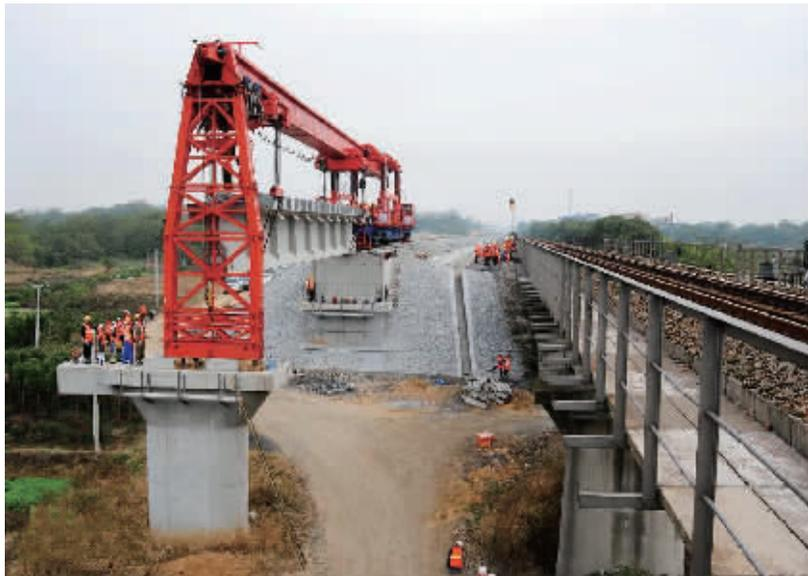
10月28日,中铁二十四局的施工人员在九景衢铁路湖口段为跨九景高速特大桥架设第一孔32米T梁。目前,九景衢铁路已全面进入架梁施工阶段。九景衢铁路为国家一级双线电气化铁路,设计时速200公里,建设里程333.33公里,线路西起江西省九江市,经景德镇、婺源等地,东至浙江省衢州市,全线批复总投资259.2亿元,预计2017年建设完成通车。该铁路的建设将为华中、西南地区与东南沿海地区增添又一便捷通道,对于开发沿线丰富的矿产和旅游资源,承接长三角及东南沿海产业转移,促进长江经济带建设等有重要意义。
