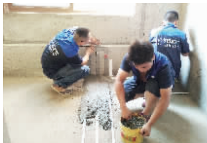
世纪方圆装饰公司施工人员在龙飞山城小区一业主家做防水基础
