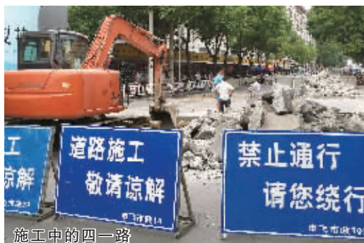
施工中的四一路
