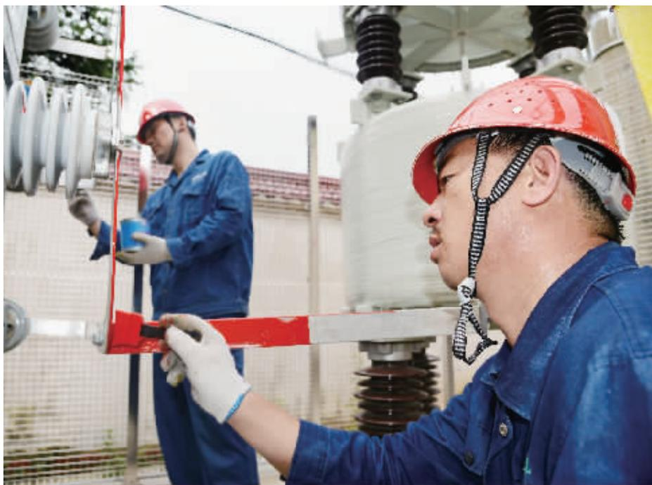
近日,新县电力公司员工对县城城南 35 千伏变电站开展改造工作,以确保其在夏季大负荷用电期间能安全可靠供电。图为工程进入收尾阶段,施工人员正在给设备刷漆。 陈巍 摄
