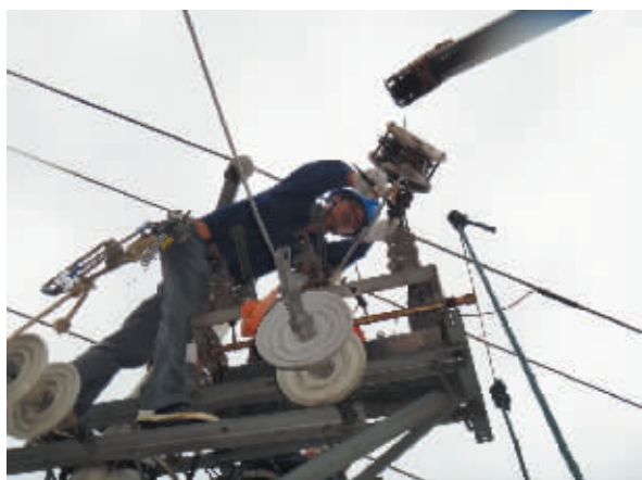
淮滨县供电工人冒雨更换开关保供电 牛青坡 摄
