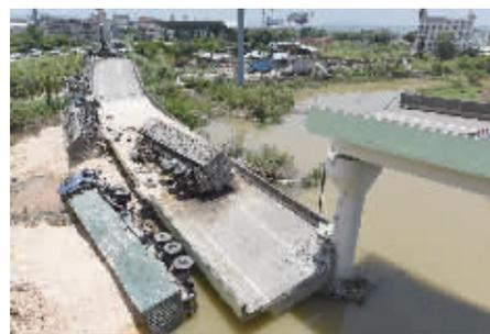
6 月 19 日 3 时 40 分,粤赣高速城南互通 CK0+224.5 匝道桥梁发生断裂。有关方面调查称,事件发生时有 4 辆满载瓷土的重载五型货车行驶在匝桥上,4 辆重载货车掉落,当场造成 1 人死亡、4 人受伤。
