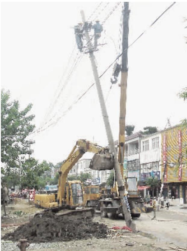
目前,我市广大农村进入“三夏”生产旺季,为保障电力供应,确保农业增效农民增收,国家电网息县供电公司白土店供电所的工作人员深入田间地头,检查线路和存在安全隐患的电线杆,并拿出资金,出动大型机具,对供电线路进行更新。图为供电人员正在更换破损的电线杆。 周磊摄
