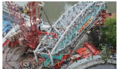
5月29日,在封闭了一个多月后,上海百年老桥浙江路桥大修工程正式启动移桥工作,借助苏州河高潮位以及前期拆卸加固工作,几百吨重的庞大桥身被施工人员整体移到100米开外的“临时厂房”里进行维修。这座桥建成于1908年,是我国仅存的几座鱼腹式钢木桁桥之一,也是苏州河上仅存的第二座钢结构老桥。(据中新社)
