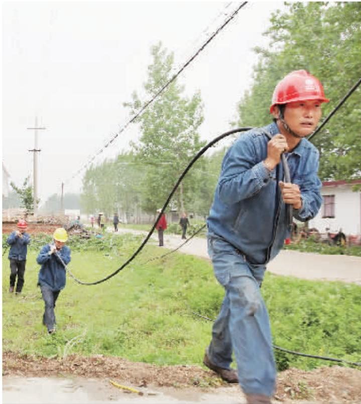
5月18日,潢川县供电公司组织 27 名工作人员对潢川县上油岗乡橡栗村 4 号台区进行改造工作,确保迎峰度夏期间电网安全稳定运行。图为施工人员进行放线工作。
