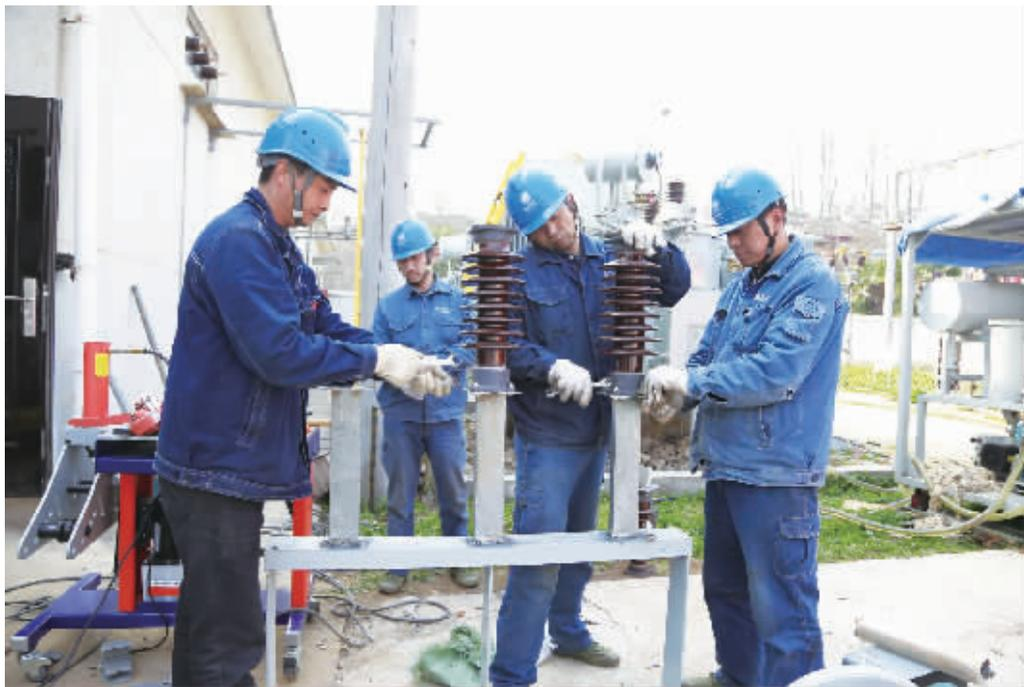
信阳供电公司致力创新,根据施工现场需求,自己动手制作工程辅助工件,以提高施工进度。图为3月29日该公司施工人员在35千伏董家河变电站增容现场,制作10千伏进线托架。 甘仁伟 摄
