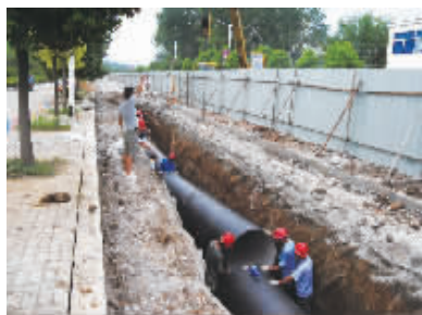
湖东取水复线——为湖东水厂取水提供双保险
