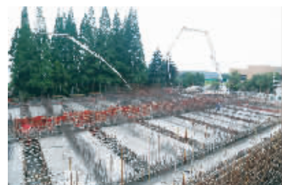
提高供水能力 确保安全供水——南湾水厂工艺改造施工现场
