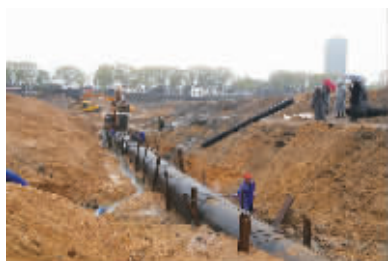
信阳中心城区供水主干管改扩建工程——漯河过河管施工现场
