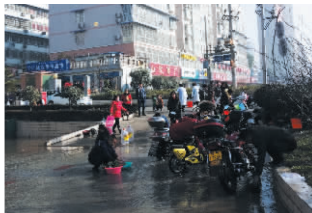
居民到漏水点接水。
