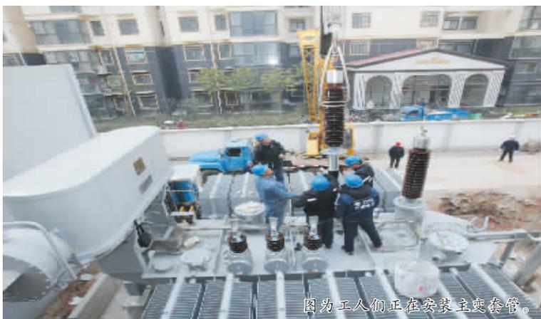
图为工人们正在安装主变套管。
