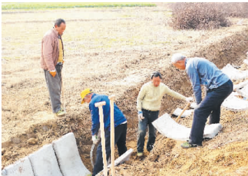
入冬以来,罗山县青山镇调拨专项资金50万元,对镇内沟渠进行综合治理。目前已清理沟渠1300米,开挖泥沙25000立方米。图为工程队员正在施工。 方建兵 摄
