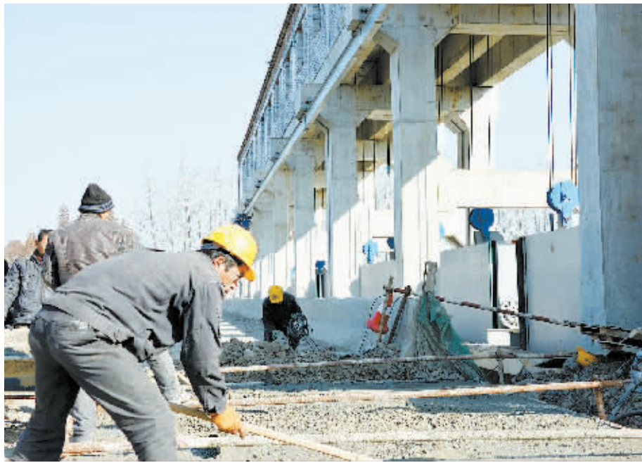
12月22日,息縣張板橋閘除險加固工程工地工人正緊張地進行道路聯結施工。入冬以來,息縣水利設施建設加緊進行。該縣2014年度最大的水利工程張板橋閘除險加固項目,是縣內淮河最大支流閘河上的一座公路橋閘,水閘由電氣控制驅動,能抵禦20年一遇的大洪水,將在日內完成公路的聯結貫通。 馬童 余江 攝
