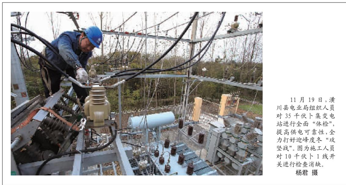
11月19日,潢川县电业局组织人员对35千伏卜集变电站进行全面“体检”,提高供电可靠性,全力打好迎峰度冬“攻坚战”。图为施工人员对10千伏卜1线开关进行检查消缺。
