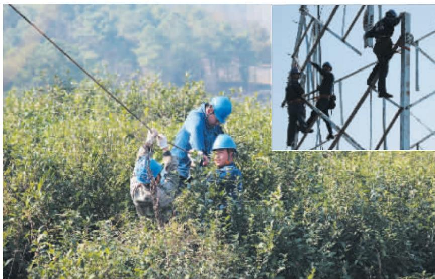
昨日，在洋河镇，电力工人们正在两个变电站之间架设供电塔，这些供电塔将用于连接洋河镇110千伏的花园变电站与上游220千伏的苍阳变电站，满足洋河镇家居小镇的用电需求。每个供电塔全高42米，重7.3吨，塔身搭建全靠人工完成。图为电力工人正在紧张地搭建22号供电塔。
