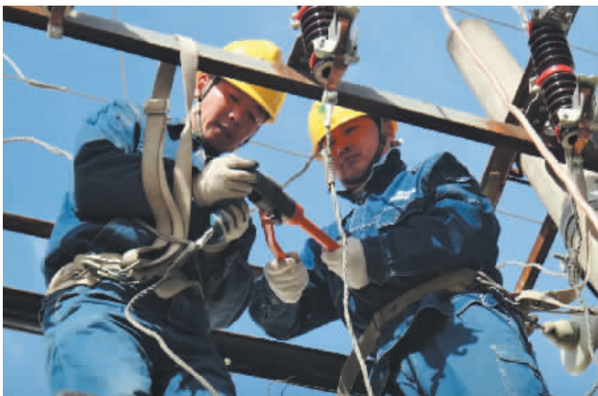
淮滨县电业局精心部署迎峰度冬工作,提前检查配网设备安全隐患,并及时进行消缺,确保其安全可靠供电。图为11月3日,该局北城供电所人员对315千伏安王营公用变压器隐患进行消缺。 牛青坡 摄
