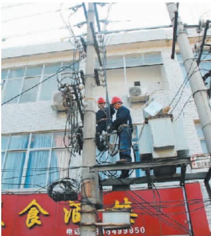
10月26日,光山县电业局6名员工正在老城区为兴隆南路02号配变台区更换老化、受损的低压出线、线夹和互感器,保证配变健康安全运行,确保居民冬季安全可靠用电。连日来,该局配电服务中心联合紫水供水所员工抢抓配网消缺的“黄金季”,集中施工力量对城区配网部分老旧配变台区和高低压线路进行保养维护、更新设备、改造升级,力争在冬季负荷高峰来临之前完成消缺改造任务,进一步优化城区居民用电环境,确保居民迎峰度冬期间用上放心电。张磊 摄
