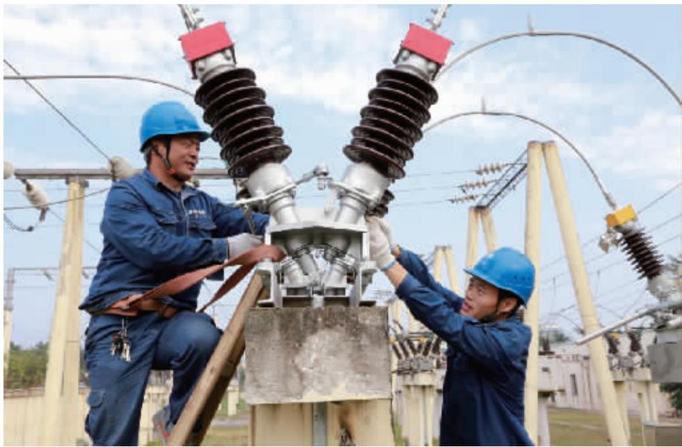
本周我市天气晴朗,秋高气爽,正是电力设备检修的黄金时间。为了确保我市电网安全度冬,信阳供电公司抢天夺时,趁着大好天气迅速开展秋季检修工作。图为10月23日上午,供电工人在110千伏五里墩变电站仔细检修。(首席记者 张方志 通讯员 甘仁伟 摄)
