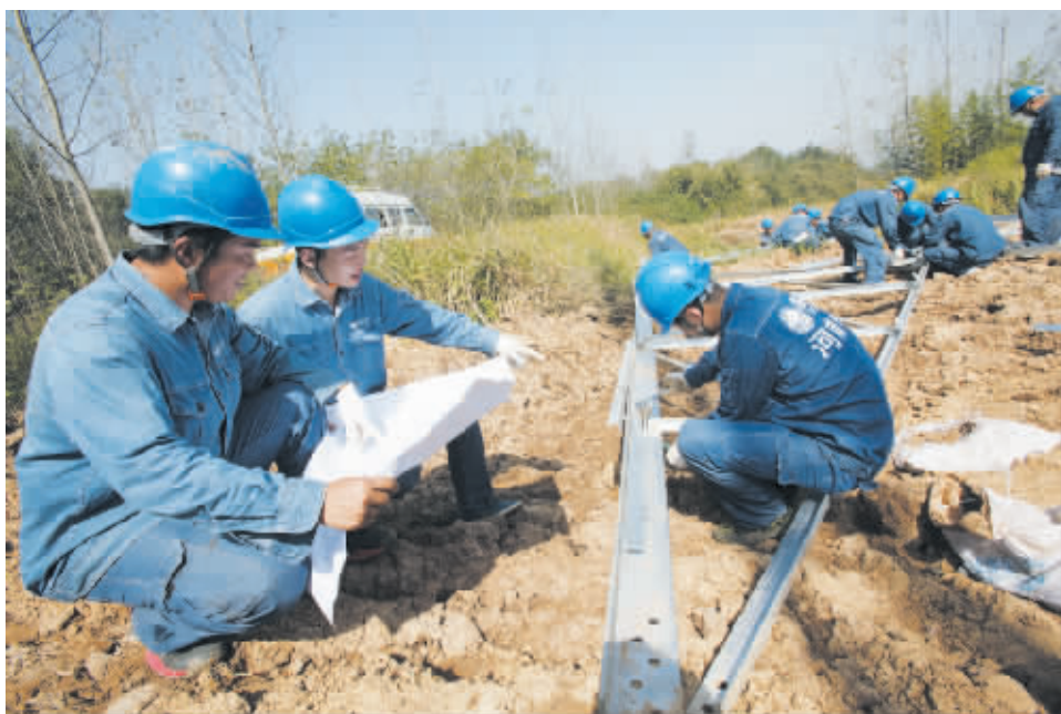
10月7日,茗阳至花园双回110千伏线路施工现场如火如荼,施工人员全线铺开,立塔放线工作正紧锣密鼓地开展。国庆长假期间,信阳供电公司电建施工人员坚守一线,全程奋战在电网建设工地上。 杨帆 摄
