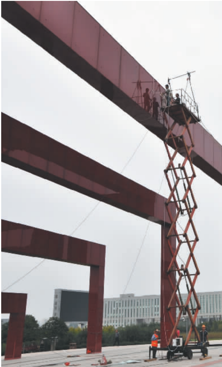
昨日下午16时许,记者在百花园看到,三名工人在机器人的帮助下,升高至16米的高空,给百花之窗更换破碎的玻璃。工作人员说,由于风吹日晒,常年亮灯的百花之窗玻璃会出现破损现象,为了不影响整体美观,他们会定期检查并更换掉破损的玻璃。 本报记者 吴楠 韩蕾 摄
