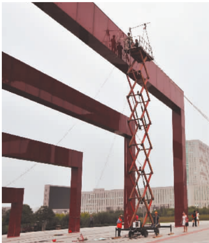
昨日下午 4 时许，记者在百花园看到，3 名工人在机器的帮助下，升至 16 米的高空，给百花之窗更换破碎的玻璃。
