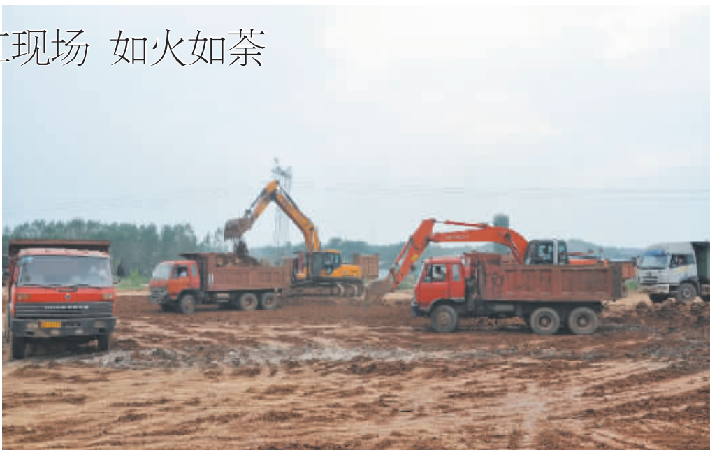
昨日,记者在金牛物流产业集聚区建设施工现场看到,工人们在各自岗位上紧张有序地忙碌着,工地上挖掘机、压路机、推土机、运料车来回穿梭,一派如火如荼的建设景象。据了解,该产业集聚区坚持以项目建设为抓手,强力推进基础设施配套建设,不断完善园区功能,提升承载能力,为项目入驻和企业的发展创造更加优越条件。图为施工现场一角。
