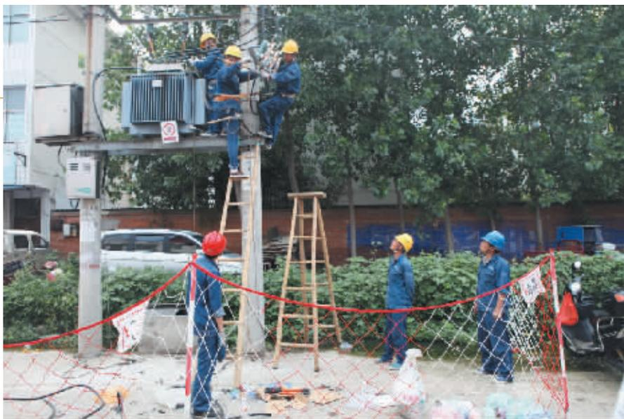
连日来,淮滨县电业局加紧对辖区内的高低压线路以及配变进行巡视和消缺,以确保全县居民清凉度夏。图为 8 月 4 日,北城供电所人员将棚西公变低压刀闸由配电柜箱内移出,防止高温低压刀闸出线烧坏。
