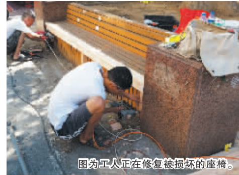
图为工人正在修复被损坏的座椅。
