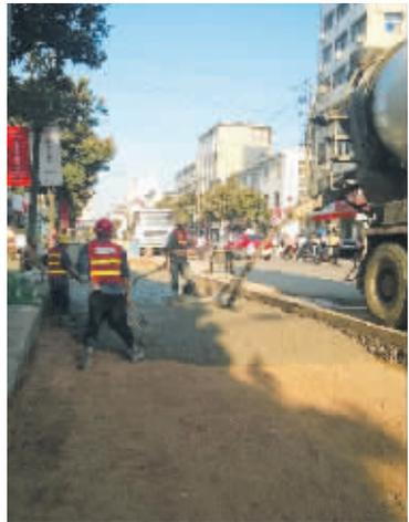
东方红大道综合改造工程开工以来,豫鑫市政公司积极克服地下管线复杂、天气酷热等多重不利因素,科学统筹,强力推进,已完成污水管线敷设450米,自来水管线敷设500余米,一周内道路北侧混凝土可全部恢复完毕,目前已完成总工程量的30%以上。图为豫鑫市政公司工人正在东方红大道浇筑混凝土垫层。 邱伟 摄
