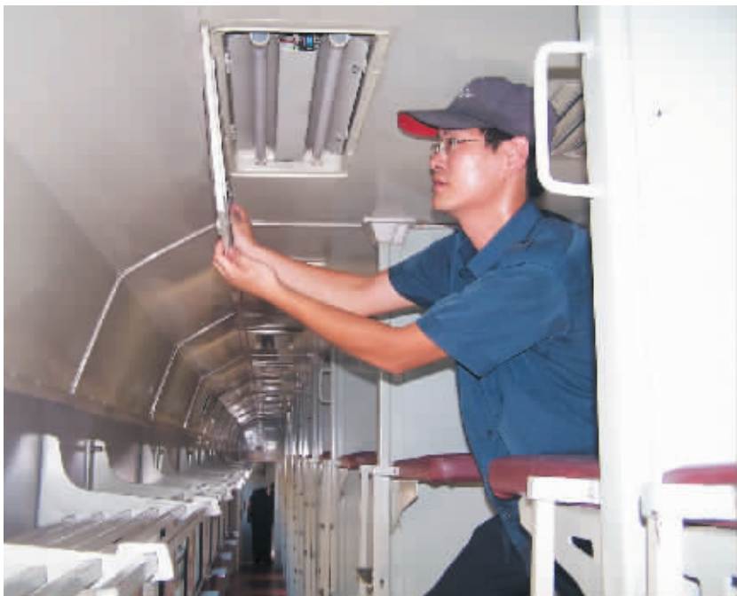
为了保障铁路“7·1”新运行图实施后的客车安全、舒适,武昌客车车辆段信阳运用车间加强了列车设备设施的维修和保养,确保暑期旅客运输安全。图为7月10日,该车间职工在闷热的车厢内检修列车服务设施。方昉摄
