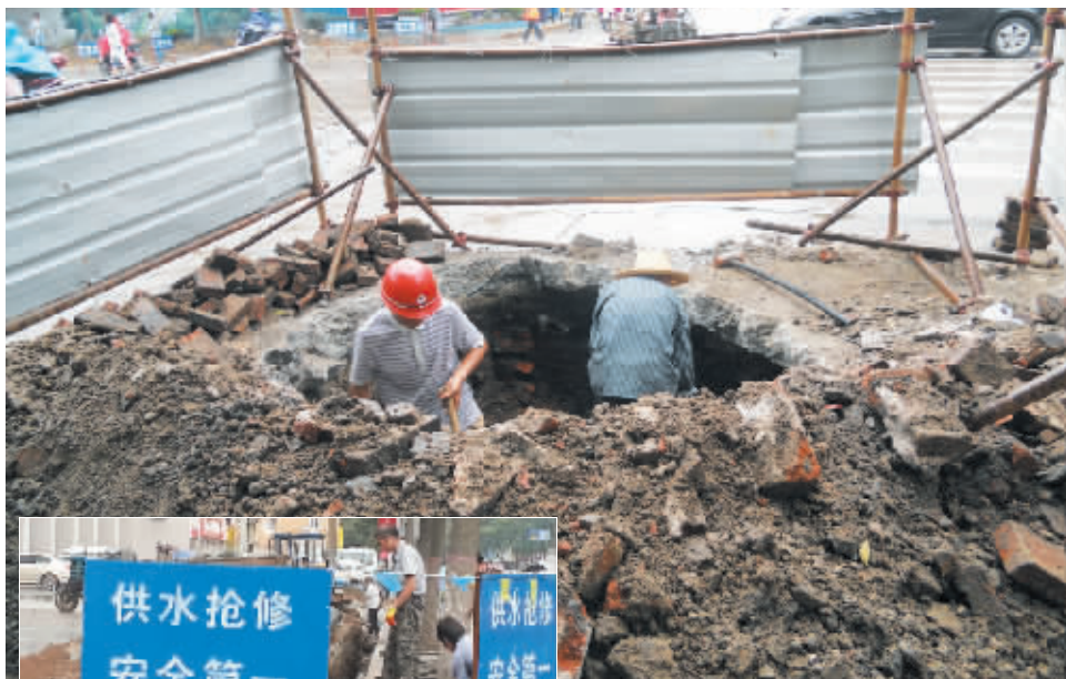
图为铺设水管的施工现场 首席记者 张方志 摄
