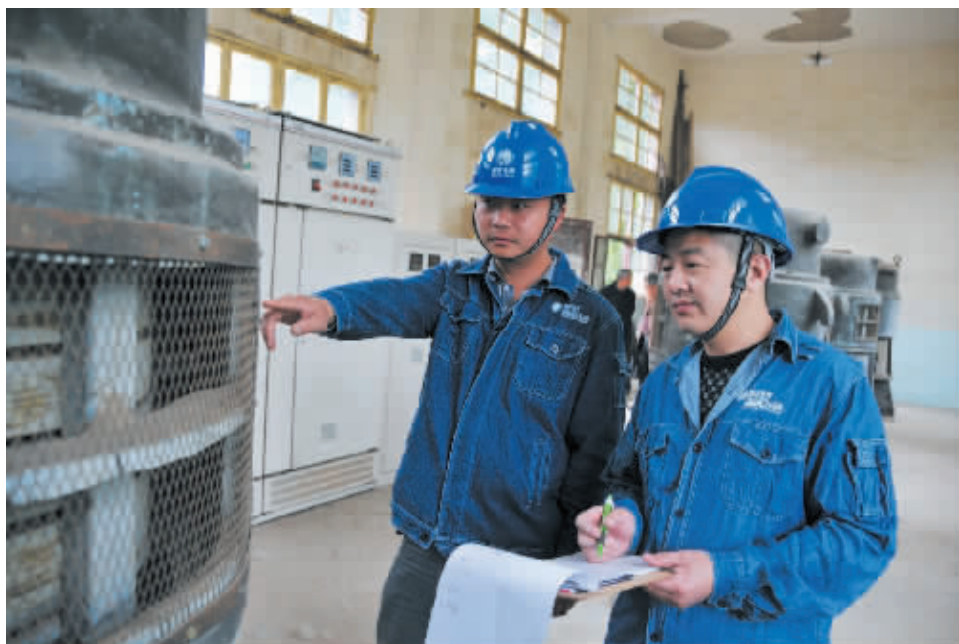
从5月14日开始,固始县电业局组织技术人员对全县9个乡镇、25座排涝网站进行专项安全用电检查,确保排涝网站的电力设施在汛期正常运作。 高伟 张杰 摄
