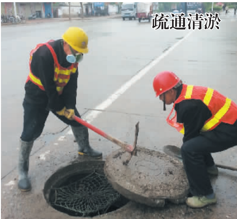
近期,豫鑫市政公司全力投入到创卫攻坚战中来。结合工作职能,精心组织施工力量对局管道路、人行道及排水设施进行全面普查和维修疏通,并为即将到来的汛期做好准备。图为昨日市政工人正在对平桥大道排水系统进行疏通清淤。本报记者 黄慧 摄
