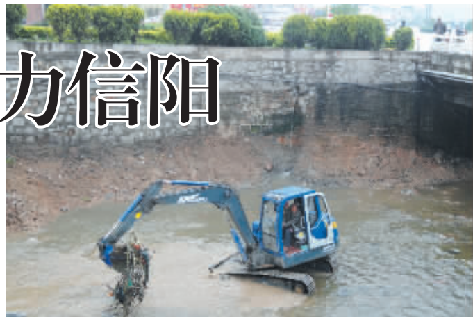
近日,浉河区五星办事处七里棚村出动大型机械,清理浉河近百米河床的淤泥与垃圾。在两天时间内,共清运垃圾100多车,不仅疏通了河道也美化了环境。图为18日下午,挖掘机在界河宝石桥下面清理垃圾时的情景。 本报记者 张勇 摄
