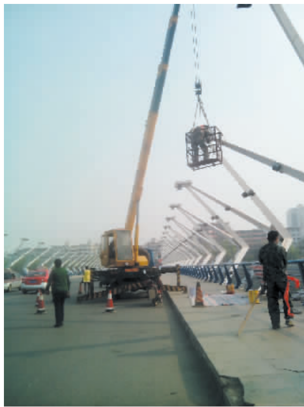
为迎接第22届信阳国际茶文化节,营造节日气氛,进一步创造干净有序、美好和谐的城市环境。近期,市政部门组织人员对市区的一些桥梁护栏、灯架进行了油漆刷新。图为关桥上工人正在对灯架刷新。 本报记者 徐杰 摄
